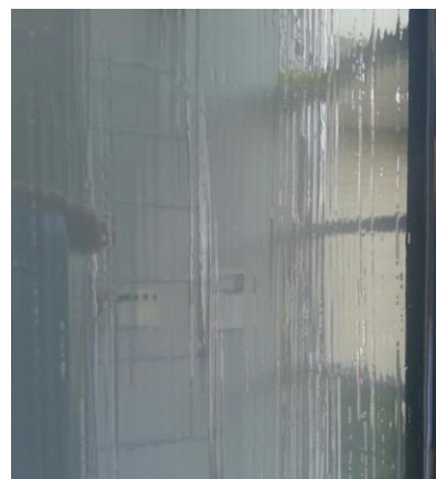
defecten kwastapplicatie
