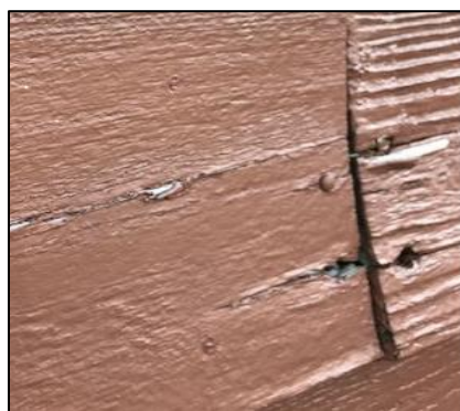
Spanning, kromtrekken en scheurvorming
