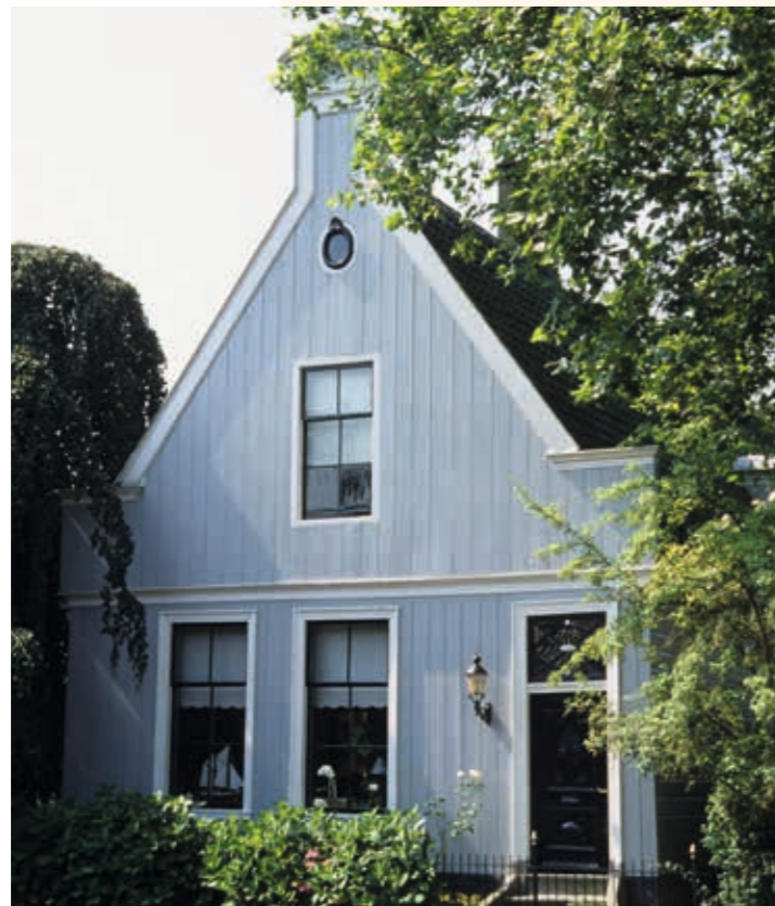
Boonstoppel lakken zijn waterdampdoorlatend en elastisch. De laklaag beweegt mee met de werking van het hout.
